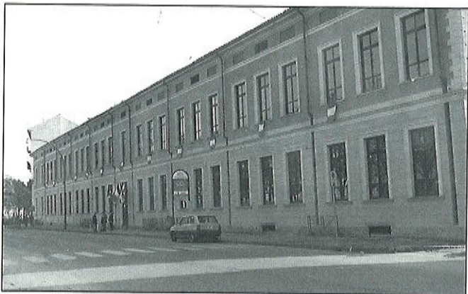
Inquadratura della scuola appena terminati i lavori
