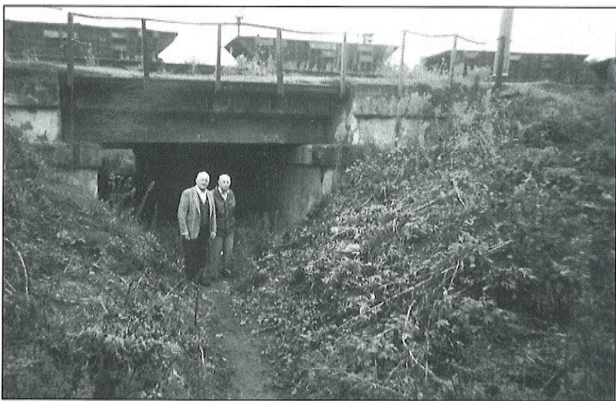
Il sottopasso della fatidica ferrovia di Nikolajewka
