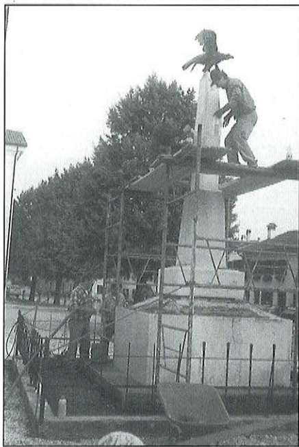
Il monumento di Fossalunga imbragato per i lavori di restauro
